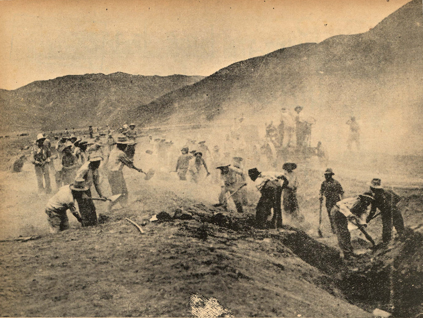
Nuestros obreros trabajando fogosamente en la carretera Huánuco- Pucallpa
