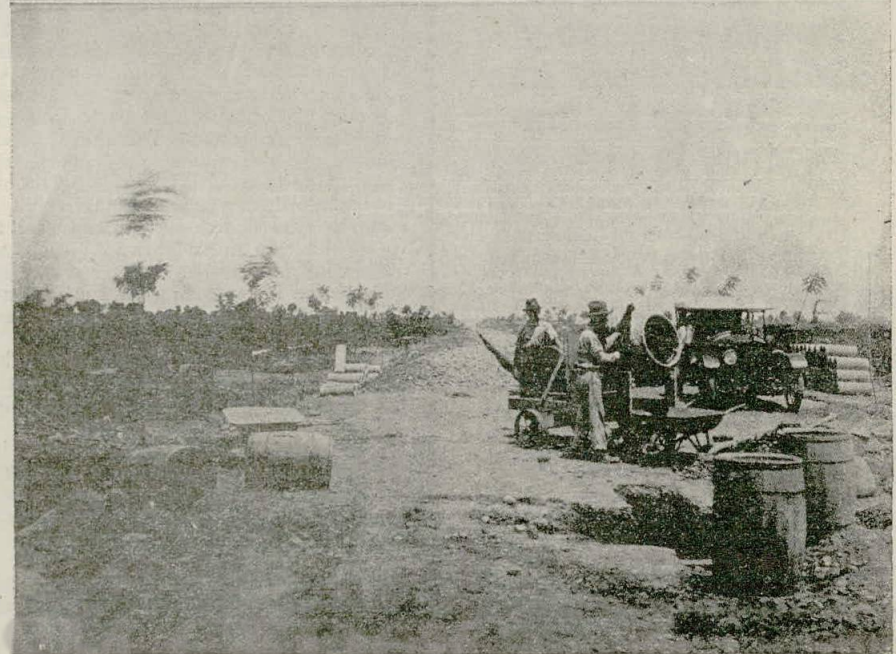
(2) Las obras de desagüe (3) El trabajo de las veredas y los itos de concreto que demarcan las manzanas y los lotes (4) Las potentes maquinarias para la mezcla de concreto y materiales de construcción.
