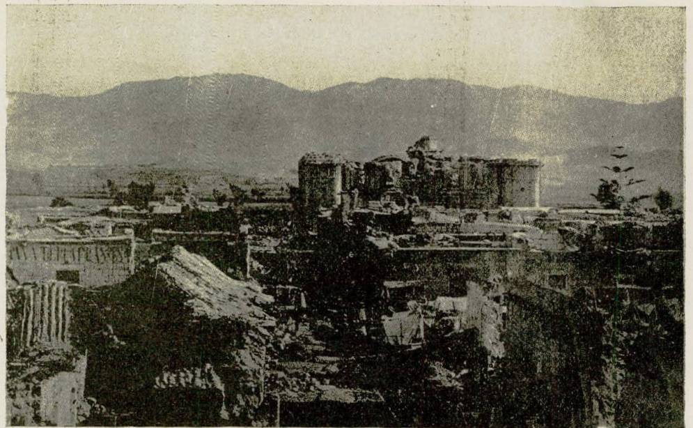
Los escombros en que quedó la Iglesia y calle de San Camilo
