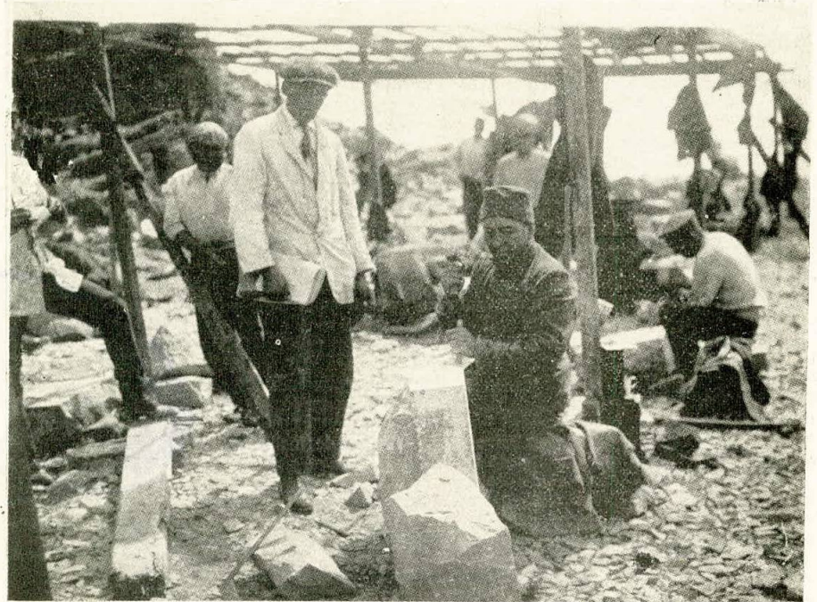
Castillo, que es uno de los penados más laboriosos y formales del Frontón, labrando las piedras que han de utilizarse en los zócalos de la finca de los señores Wiese en la esquina de Núñez y Filipinas
