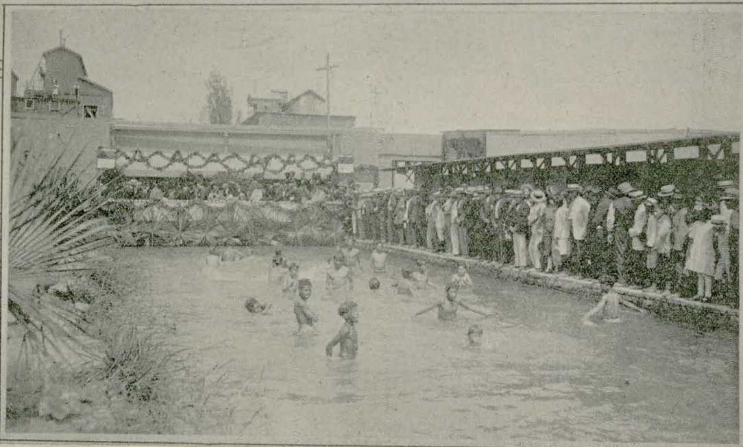
El laudable empeño del Alcalde del Rímac, Sr. Dr. Víctor Arzávalo, por conseguir el mayor progreso de su comuna, se ha visto coronado con una obra de positiva importancia: la reconstrucción de los baños populares de Otero, cuya necesidad era clamorosamente sentida. La ceremonia de inauguración se realizó el sábado en la mañana, bendiciéndola, el Hmo. Sr. Arzobispo y apadrinándola el Presidente de la República. Ofrecemos una completa información gráfica de este simpático acontecimiento.
