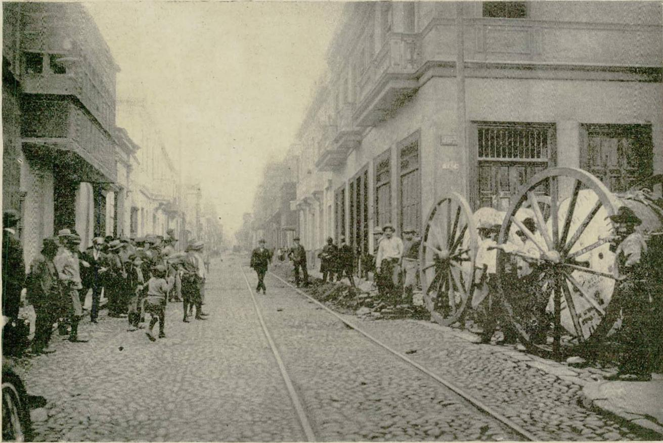
Los cables transmisores de fuerza, listos en sus bobinas para la colocación
