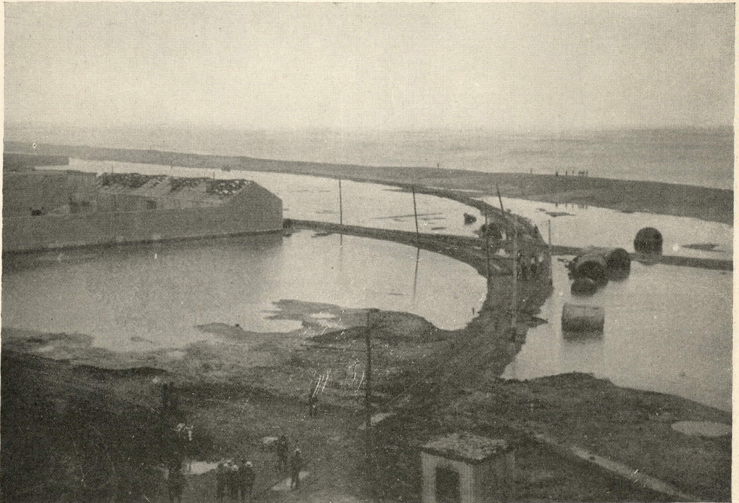
Las líneas del ferrocarril central que unen al Callao con los depósitos de Chucuito han sido totalmente minadas por el mar.
