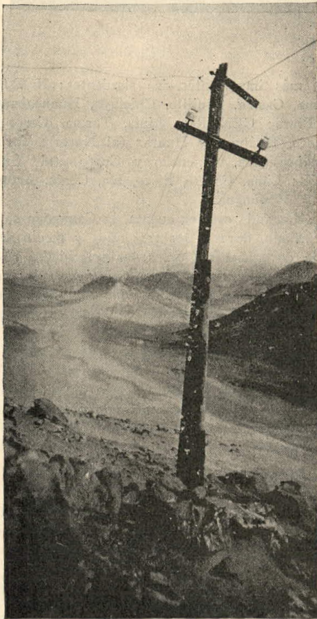
Línea antigua entre Pativilca y Huarmey (Parte de la línea principal Lima-Trujillo que ha sido reconstruida.)
