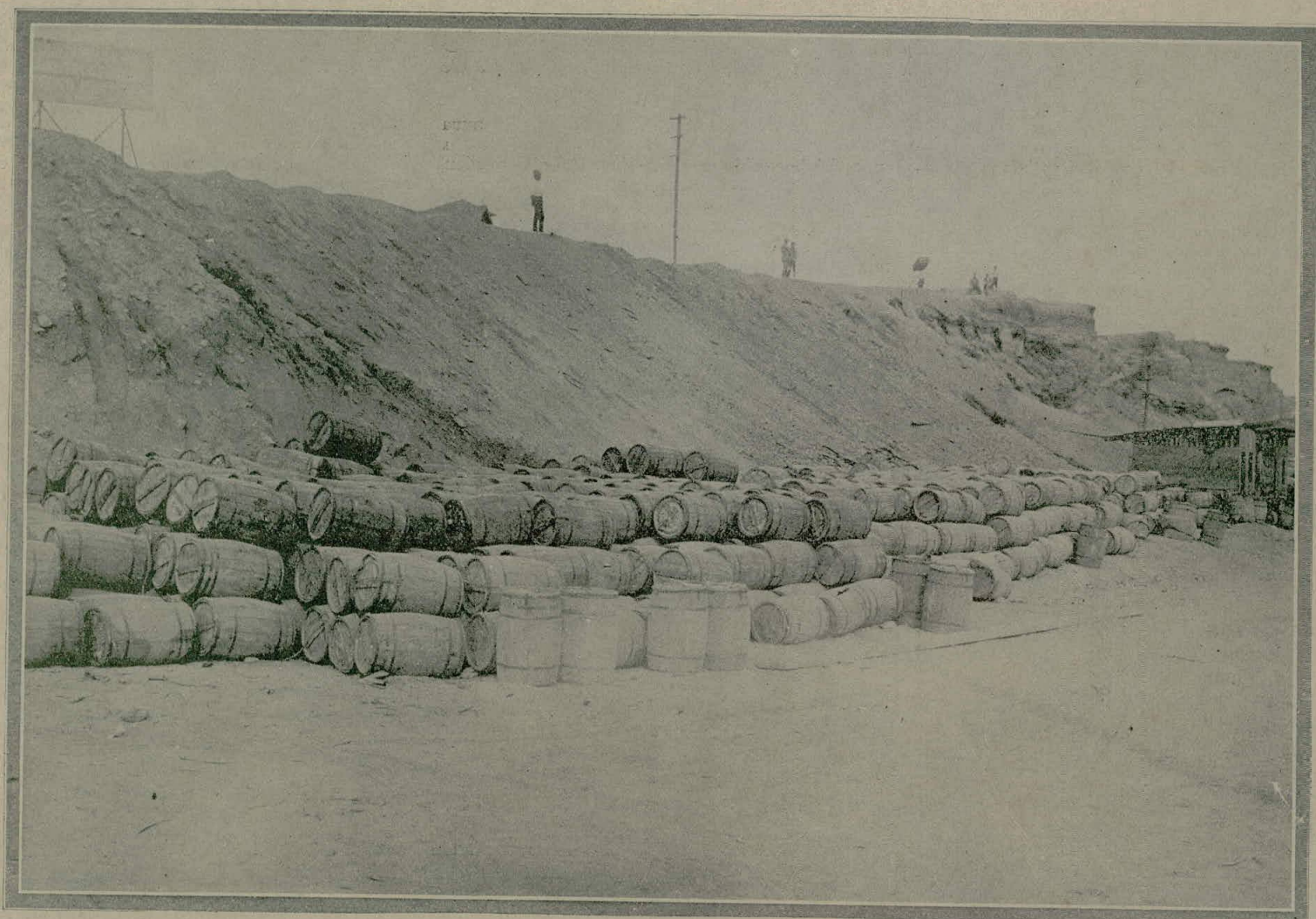
Parte del inmenso stock de 6,000 barriles de cemento que se emplearán en la colosal obra del rompeolas. Este cemento es hidráulico y especial para esta clase de trabajos.
