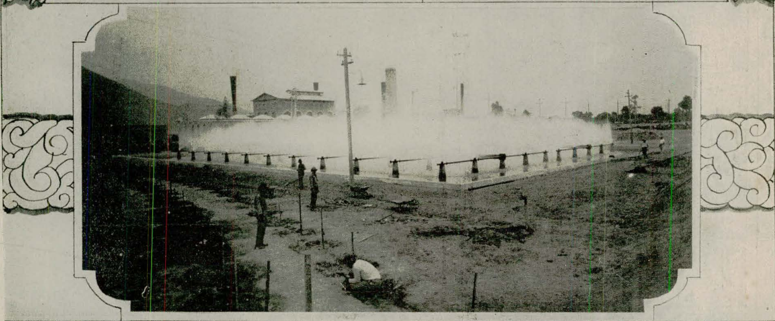
En estos fotografados presentamos el interior de la sala de calderas Tossi; sala de los dos Turbo-grupos Brown Boveri de 5,500 kw. cada uno; Bombas para el sistema de refrigeración y por último el tanque y surtidores para el enfriamiento del agua. Tal es la poderosa instalación que suscitadamente comentamos, y por la que MUNDIAL se apresura a manifestar merecido elogio.
