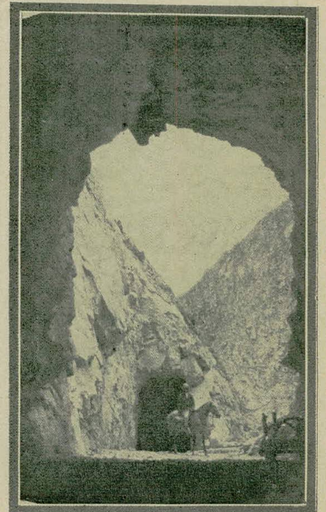
La boca de salida de un túnel y la entrada de otro en el kilómetro 41.
