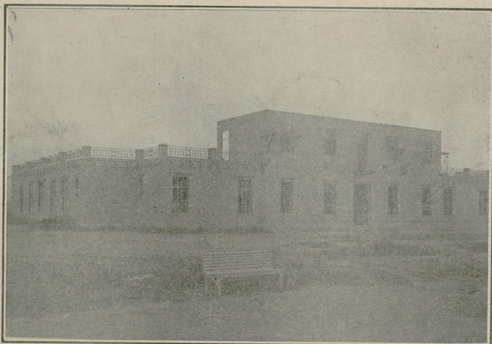
El asilo colonia de la Magdalena fué una de las obras con que más se encariñó Don Víctor Larco. Estado en que ha quedado uno de los pabellones
