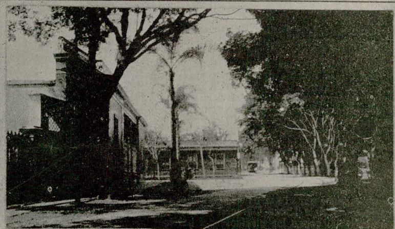
CALLE LIMA DONDE SE DISTINGVE EL PISO DE CONCRETO.
