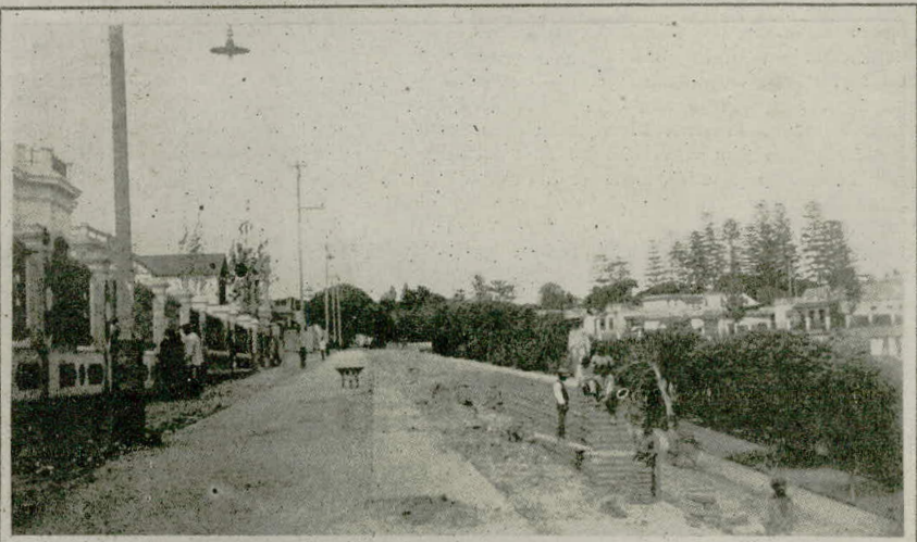
TRABAJOS EN EL NVEVO MALECON
