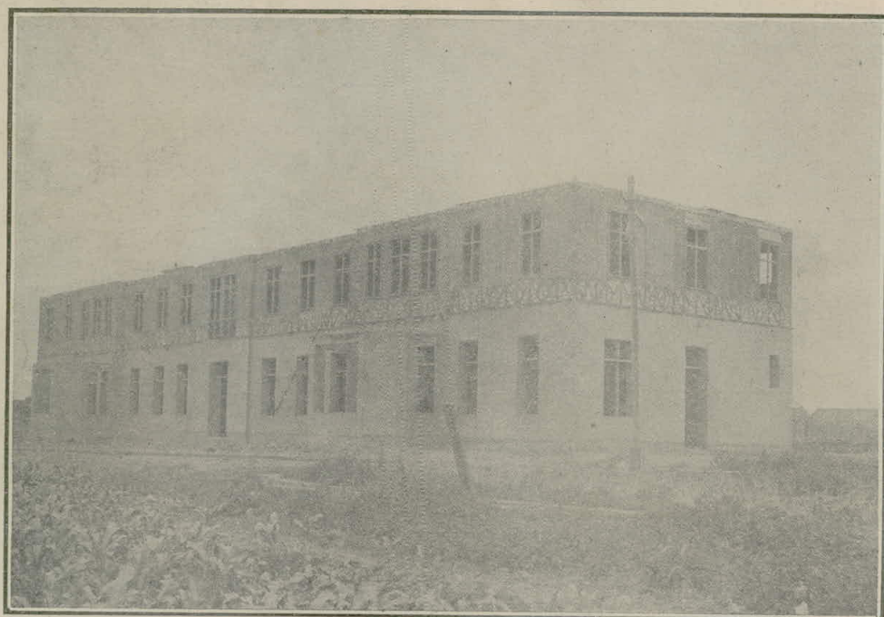
A media construcción otro departamento importante del mismo Asilo.
