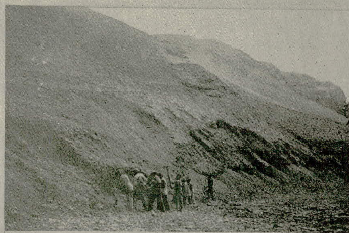
TRABAJANDO EN LA BAJADA A LOS BAÑOS.
