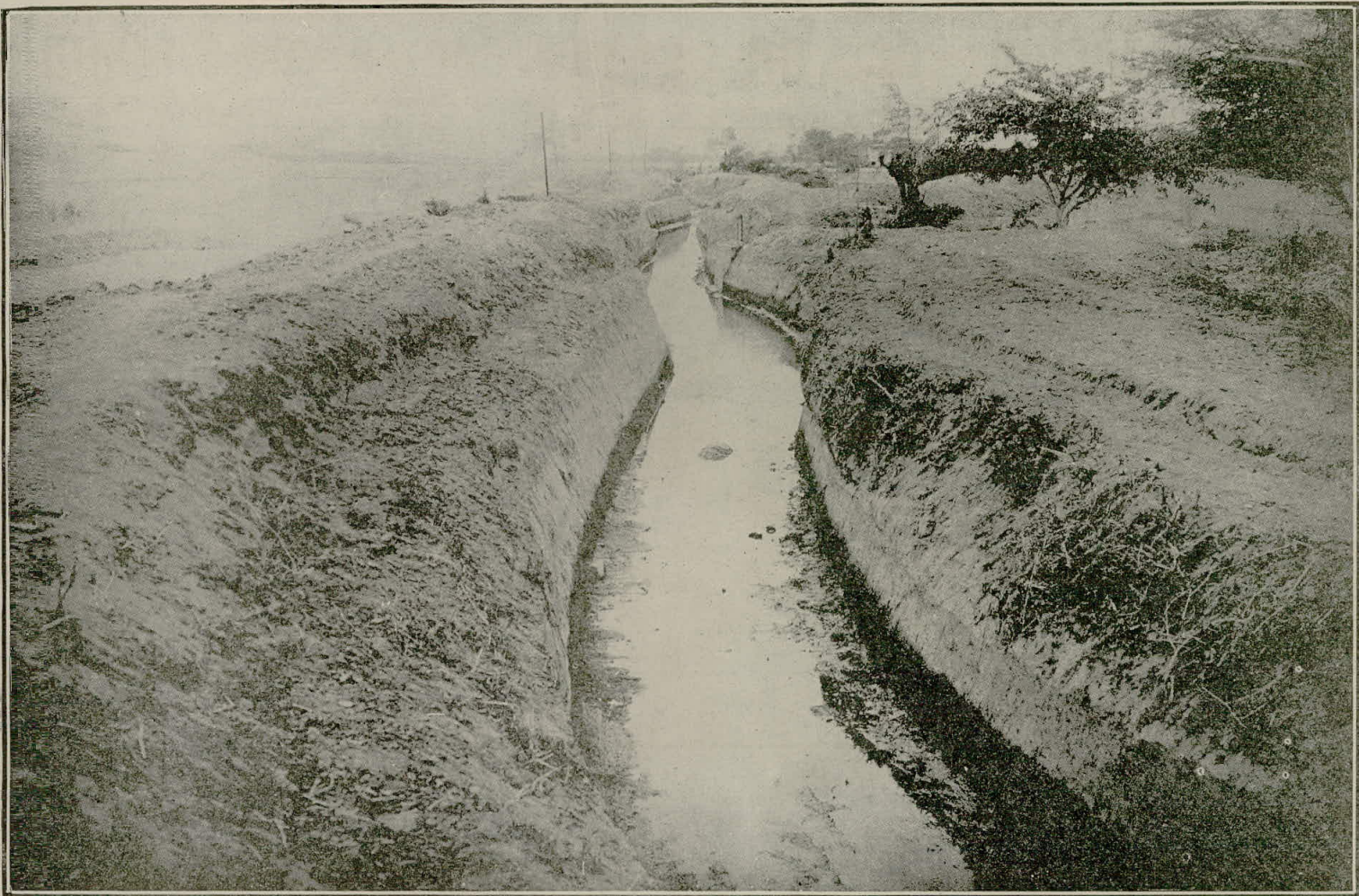
Acequia "Mochica", notable acueducto incaico que estaba en reparación
