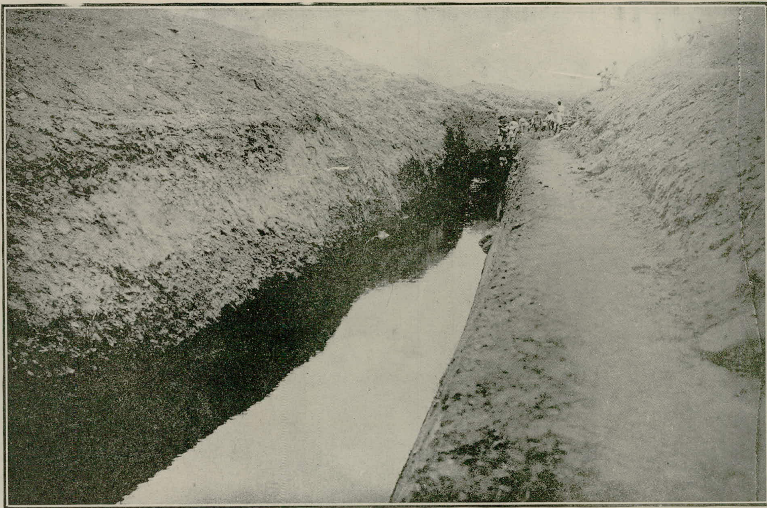
En el valle de Santa Catalina se reparaba tam bién el acueducto "Paíján"
