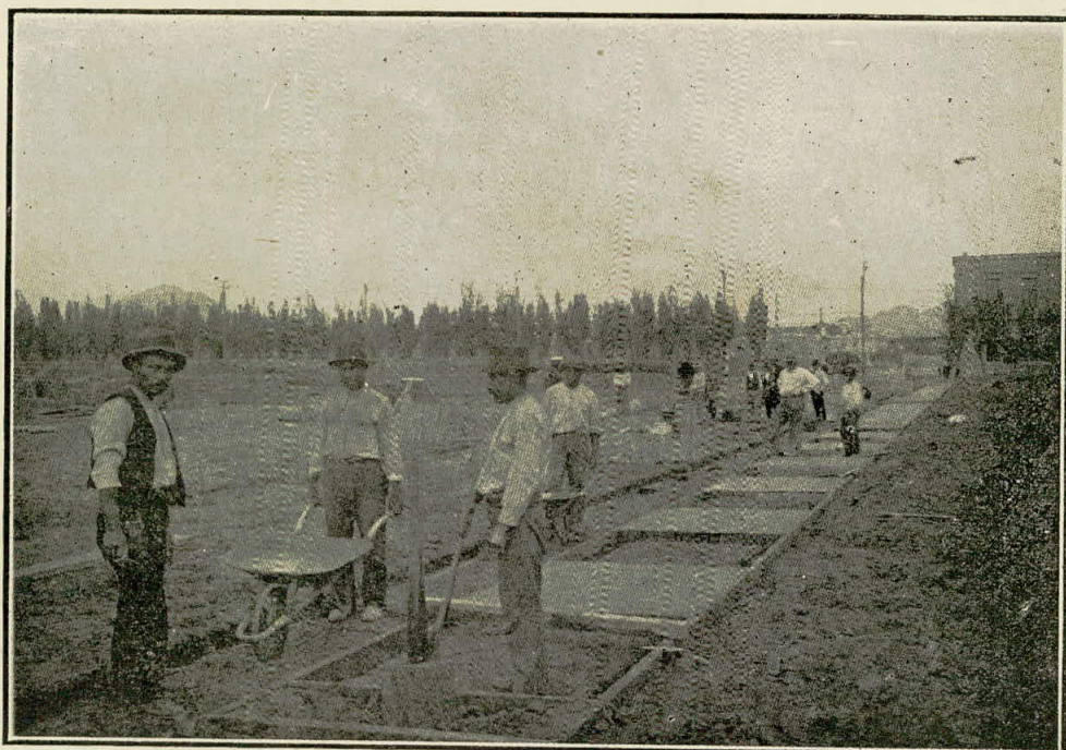
Las obras de pavimentación.—Construyendo las veredas
