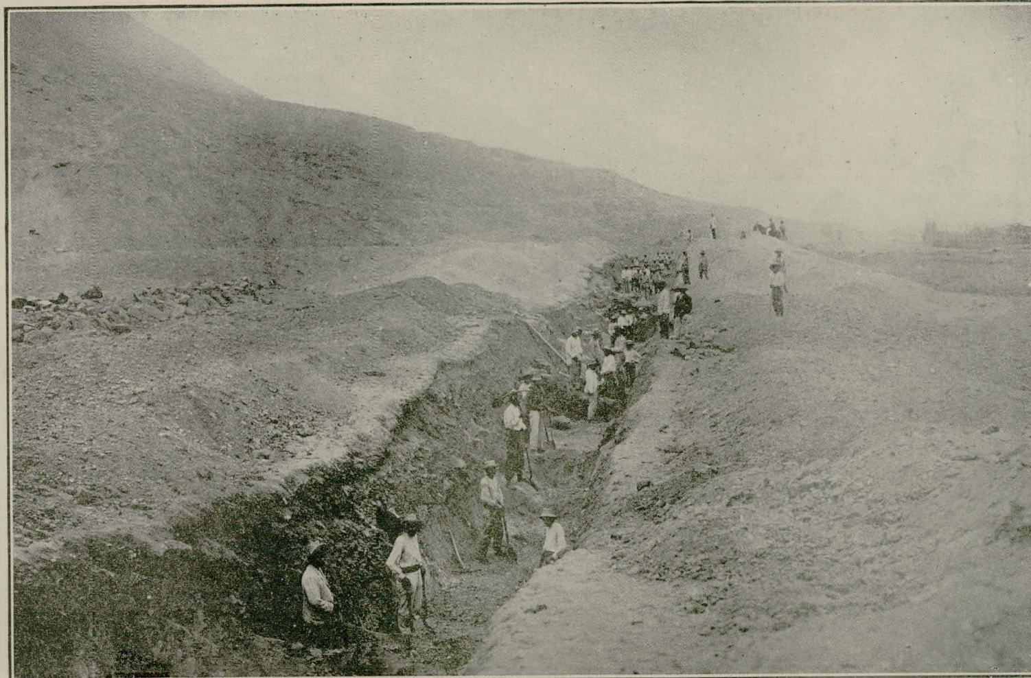
103 hombres trabajando en la reapertura de la acequia de "Troche"
