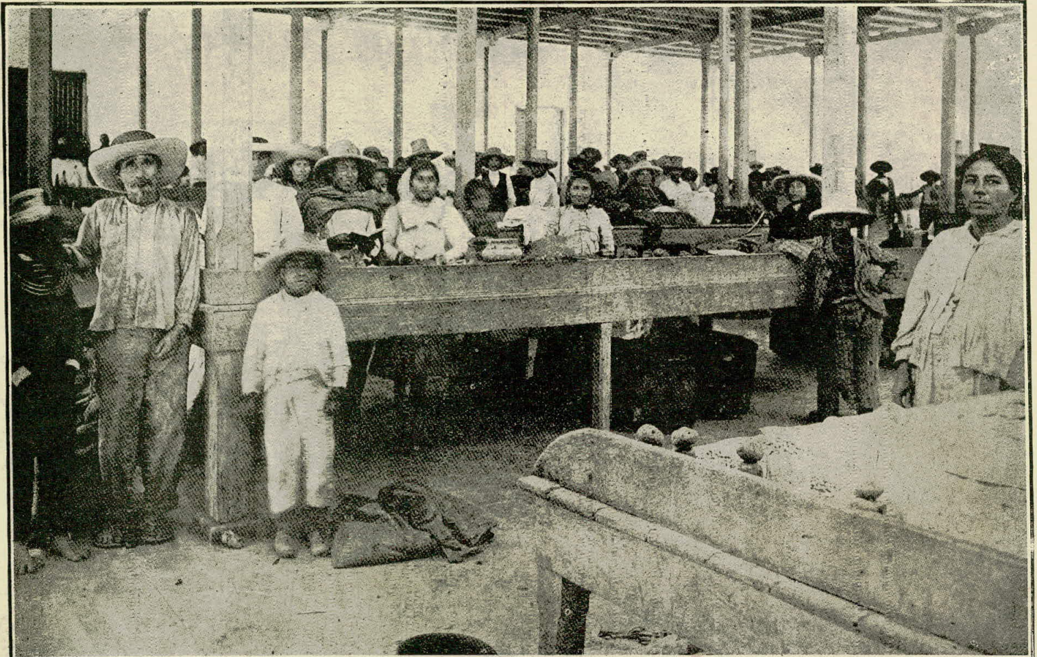
El mercado. Mucho hay en Lima y alrededores hasta hace poco que no tenían todas las instalaciones requeribles para un mercado. Esta ha sido una de las obras más plausibles de don Víctor Larco.
