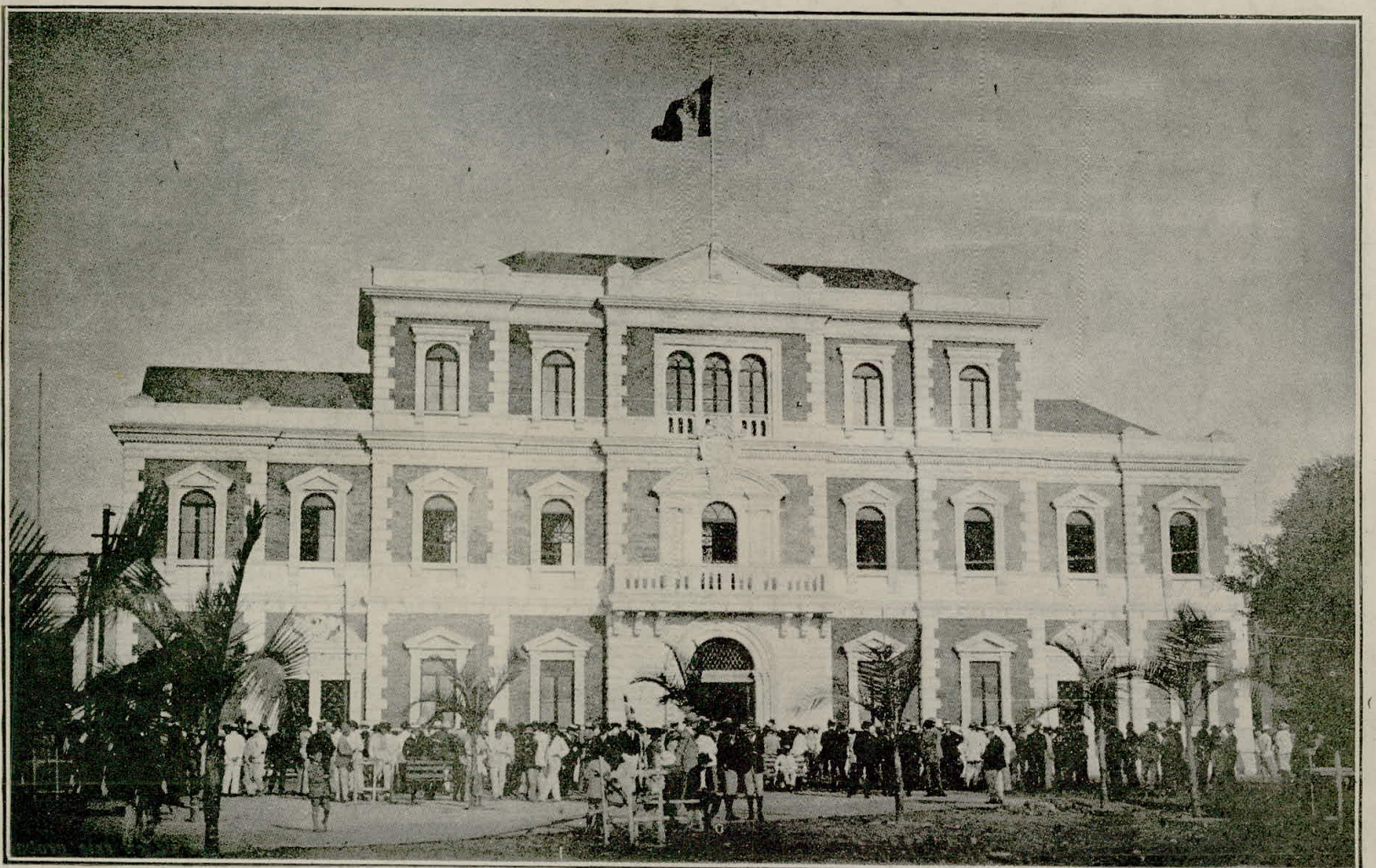
La actual Municipalidad, (ejecutada por el ingeniero Domingo Tanlango)
