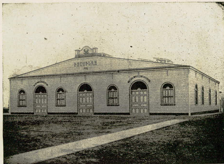
Edificio de las Escuelas mixtas de Huanchaco
