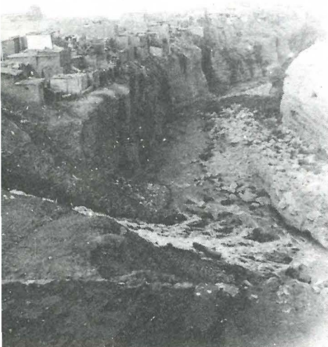
Las viviendas con estructuras y materiales inapropiados llegan a cifras impresionantes
