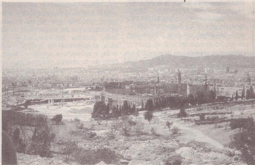
Barcelona, panorama de las obras desde Montjuïc.
