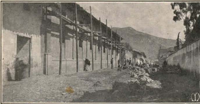
Centro Escolar en construcción
