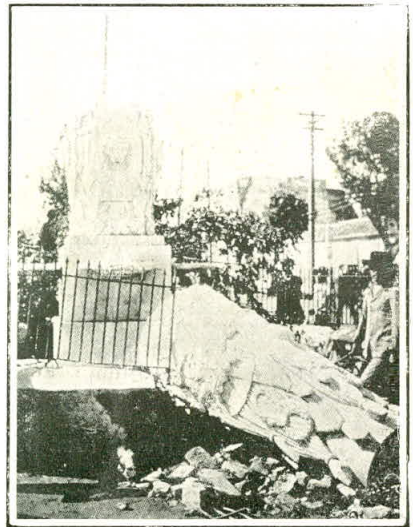
El coliseo de la alameda de Paula derribado por el viento
