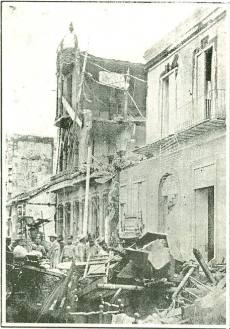
Aspecto de una casa en construcción en la calle de Neptuno, derribada por el viento
