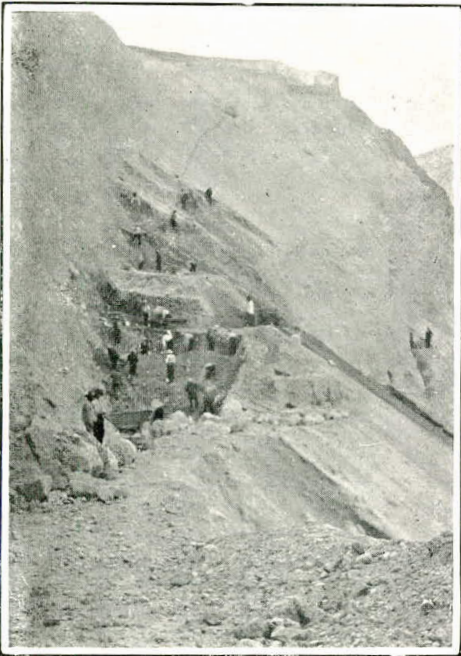
Ferrocarril de Huancayo á Ayacucho—Los trabajos en un corte
