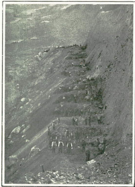
Trabajando los 20 andenes distintos á 50 metros de altura.
