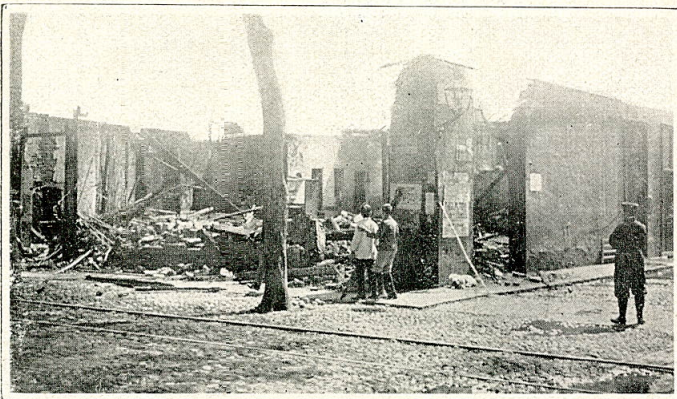
Otro aspecto de lo destruído por el fuego
