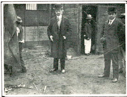
El director de salubridad presenciando la demolición
