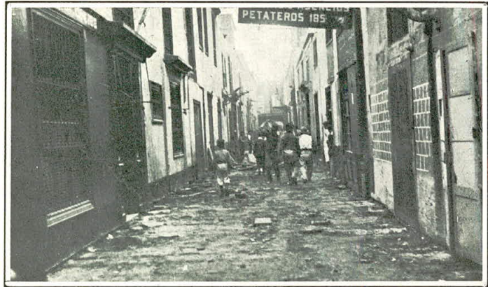
El callejón de Petateros al comenzar la demolición
