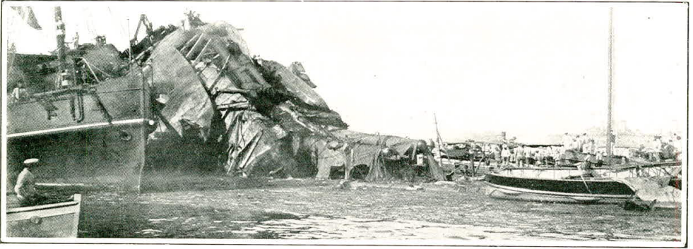
Parte del destrozado puente del «Liberté»
