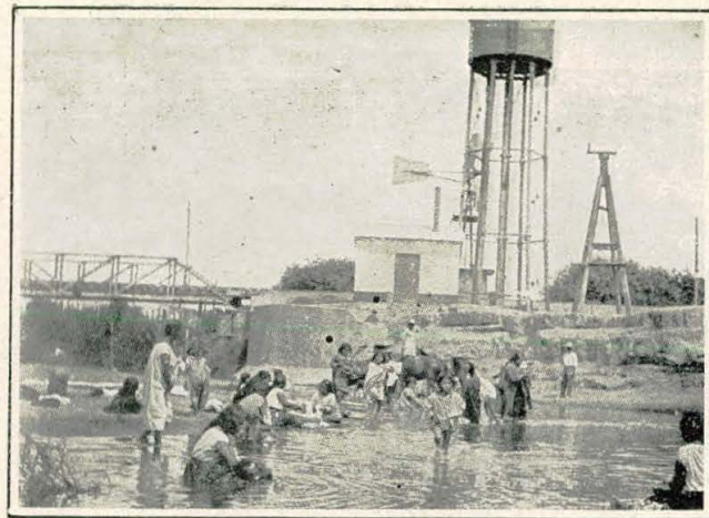
Eten.—Tanque que suministra el agua á los habitantes del pueblo á 3 kilómetros.—Envío Noya
