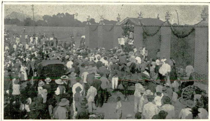
Trujillo—Instalación de baños públicos y fachada del local el día inagural
