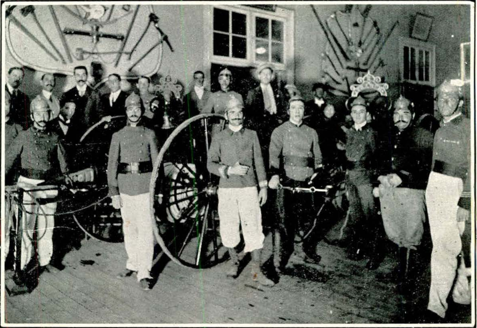
Durante el ensayo de la nueva bomba de la "France"
