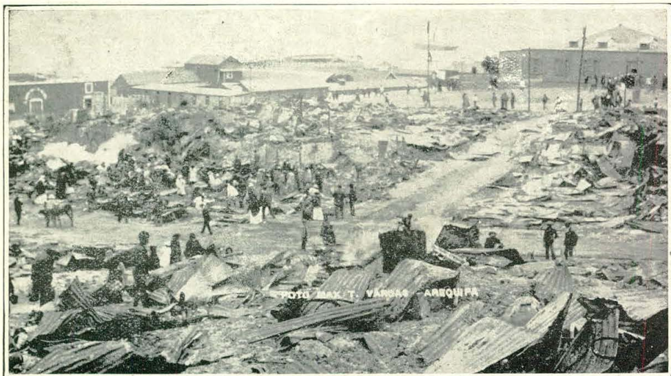
El girón del Comercio en escombros
