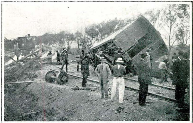
Los efectos del descarrilamiento
