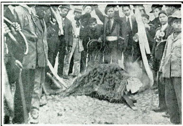
Incendio de enseres de soplones en la calle del Huevo
