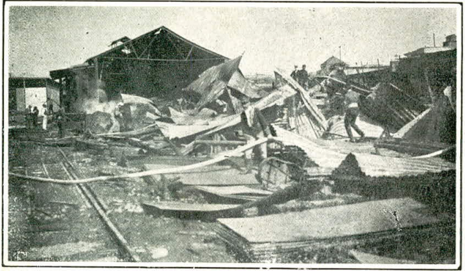
Aspecto del incendio
