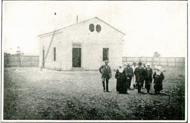
La caseta donde se ha instalado la estufa
