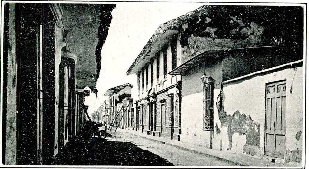
Piura - Casas destruídas por el terremoto.
