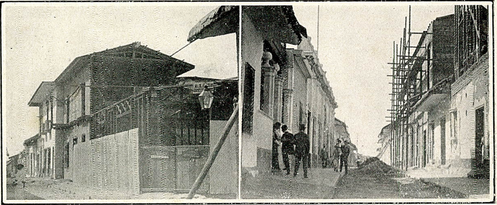
Calle de Arequipa.
