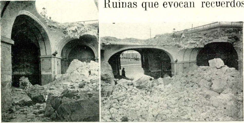
Arcadas en la nave central de la capilla de los juandedianos (después salón de máquinas de la Bomba "Lima").—Ruinas del Convento y de la capilla de San Juan de Dios y el hospital de San Diego.
