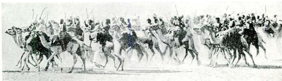
Curioso aspecto que presentan las tropas coloniales inglesas del Egipto.
