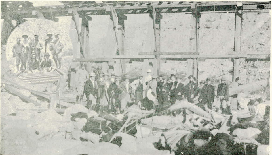
Grupo de los excursionistas bajo uno de los puentes que han sido reparados. En el círculo los mismos, nivelando la línea.
