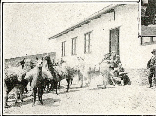
Fachada del Club Morococha
