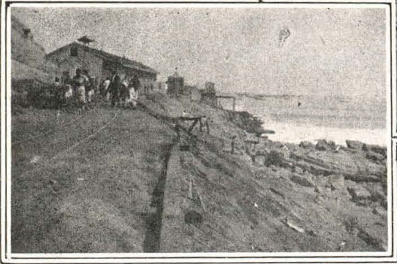
Reparando la línea férrea dañada por el fuego
