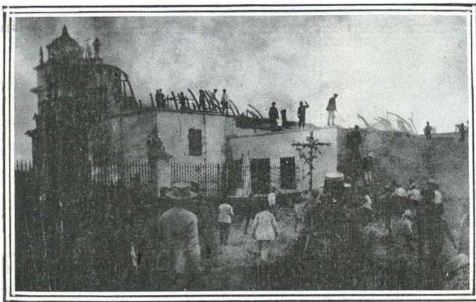
Lo que quedó de la iglesia después del incendio
