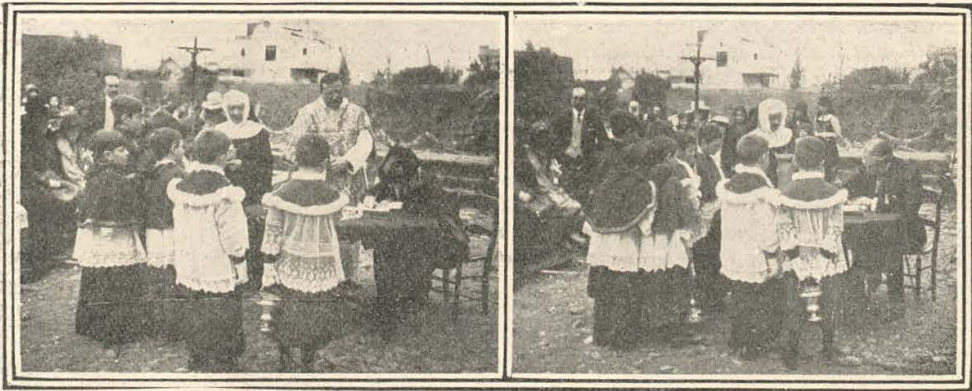
Durante la colocación de la primera piedra
