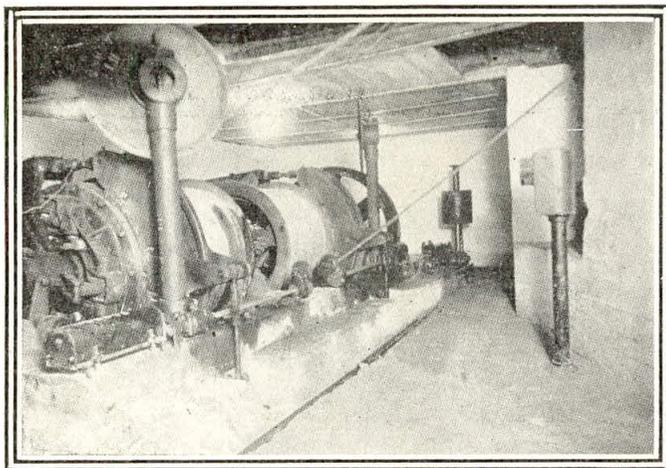
Mina "Ombla".—Vista del frente del torno eléctrico.
