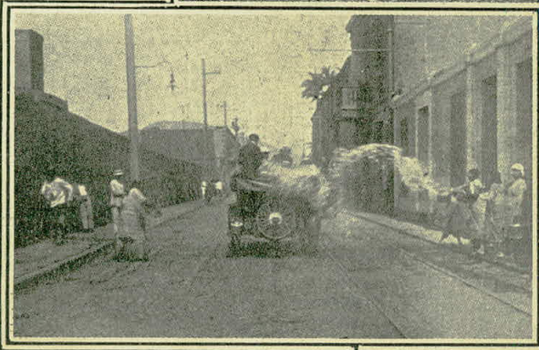
Mojando autos en la calle de La Confianza
