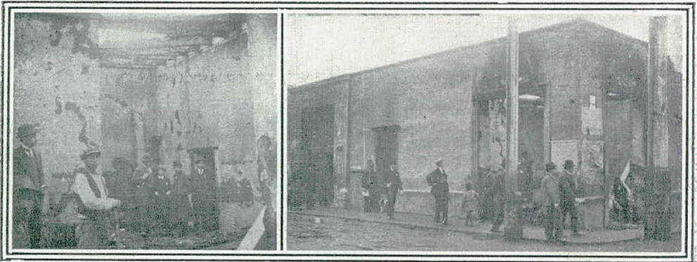
Interior de la administración de "El Comercio", totalmente destruída por el incendio.— La fachada de la imprenta de "El Comercio" tal como ha quedado después de los suce- sos del miércoles.
