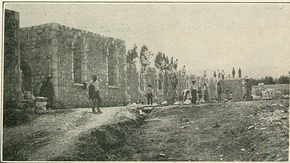
El nuevo Lazareto de Arequipa en construcción
