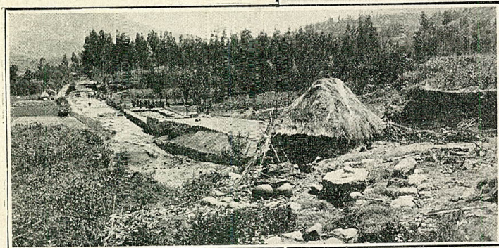
Un relleno en obra
