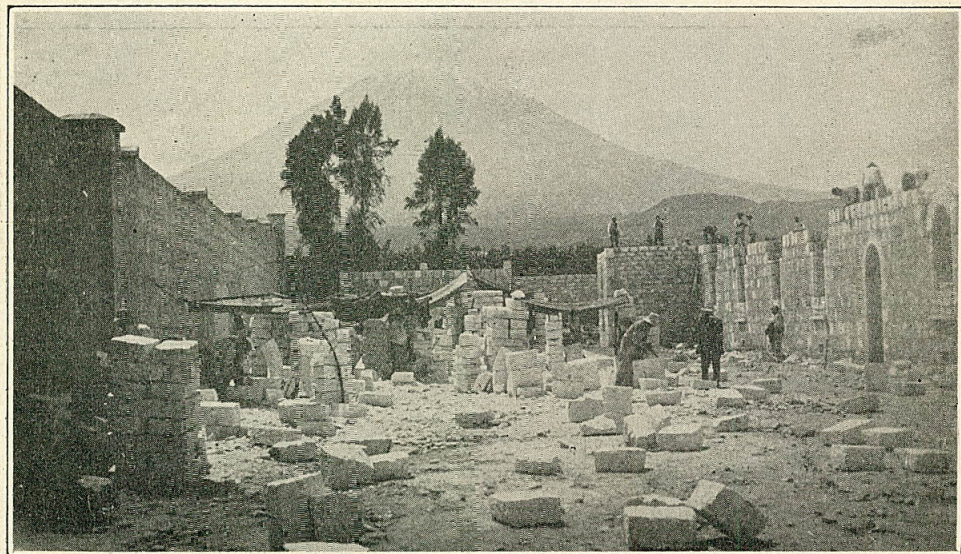
Otro aspecto de la misma obra
