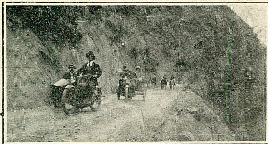
La carretera de Cerro de Pasco a Huánuco; sección concluida y entregada al tráfico.
