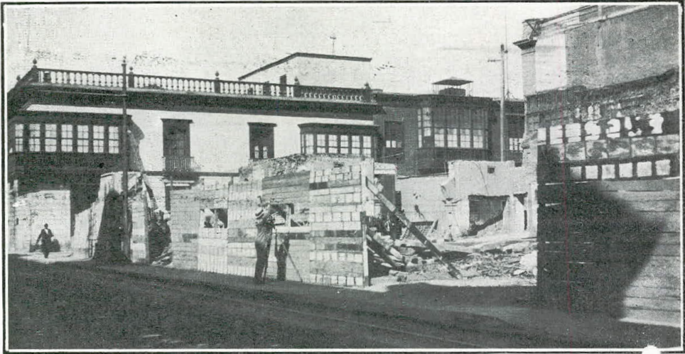
Vista general de la casa de Olavide, en ruinas
