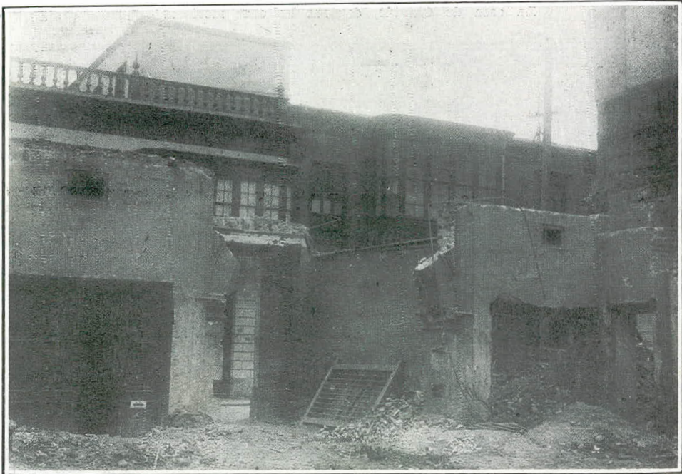
Un aspecto de la mansión, en plena destrucción
