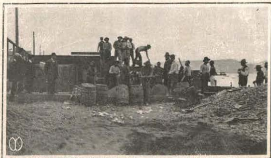
Aspecto de los trabajos que se realizan
