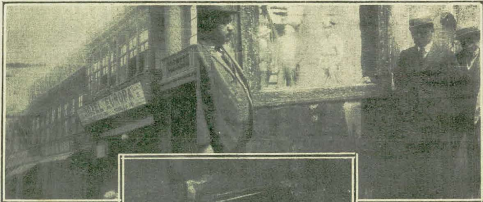
La fachada del hotel "Europa", en cuyo interior se desarrolló el incendio.
