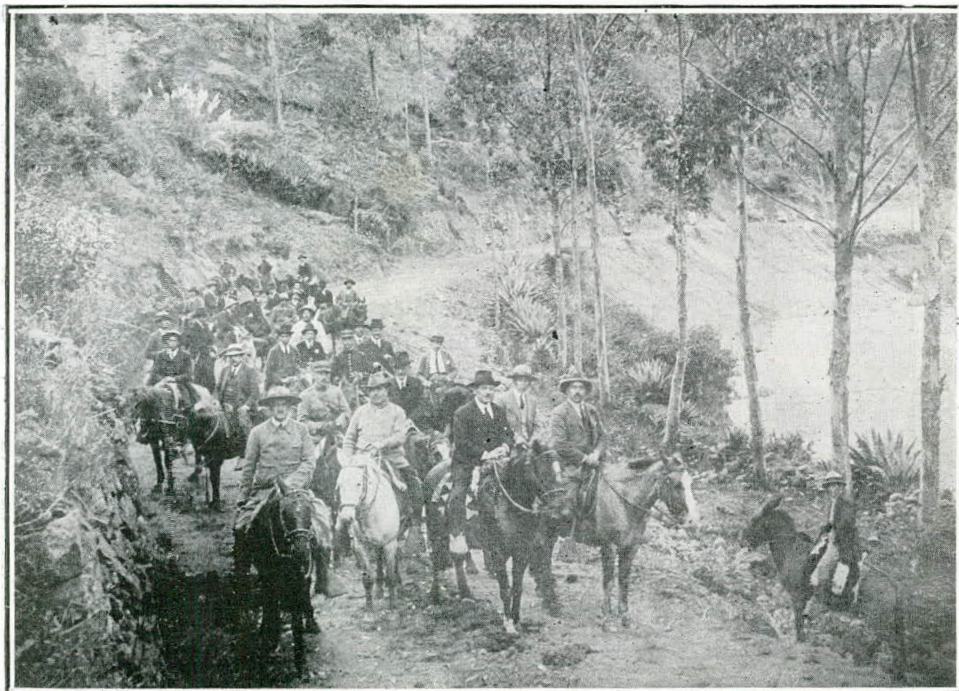
La comisión parlamentaria inspeccionando los trabajos
