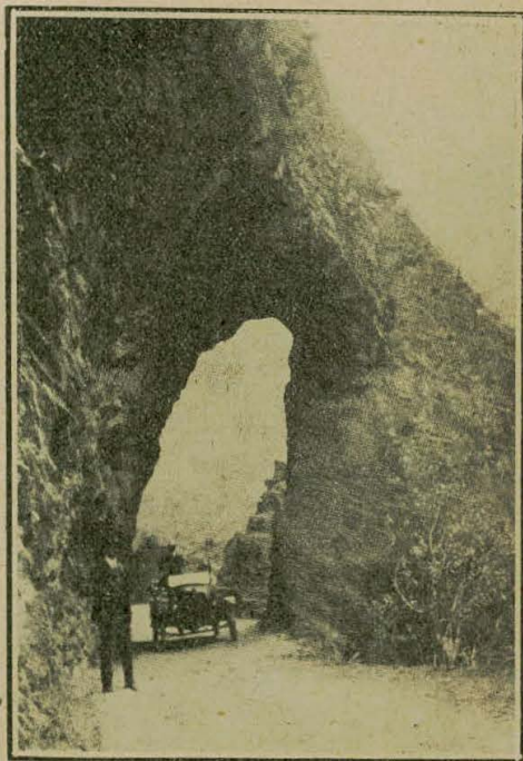
Camino arreglado para el paso de los autos
