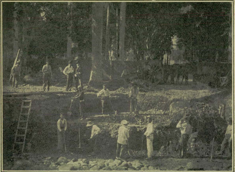
Excavaciones para construir los cimientos para recibir la "Fuente Monumental".
