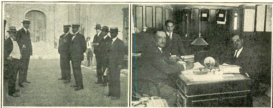
El Alcalde de Lima, señor A. Dasso, los concejales y los constructores al darse la orden de comenzar la obra. — El señor Manuel S. La Fuente, en su oficina de construcciones, sita en la calle de Mantequería de Boza.
