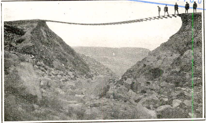
Otro aspecto de la línea destruída en el Km. 194
