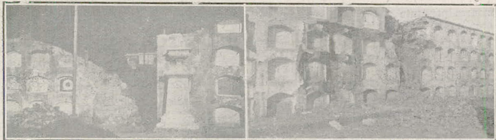
Los destrozos en el Panteón
